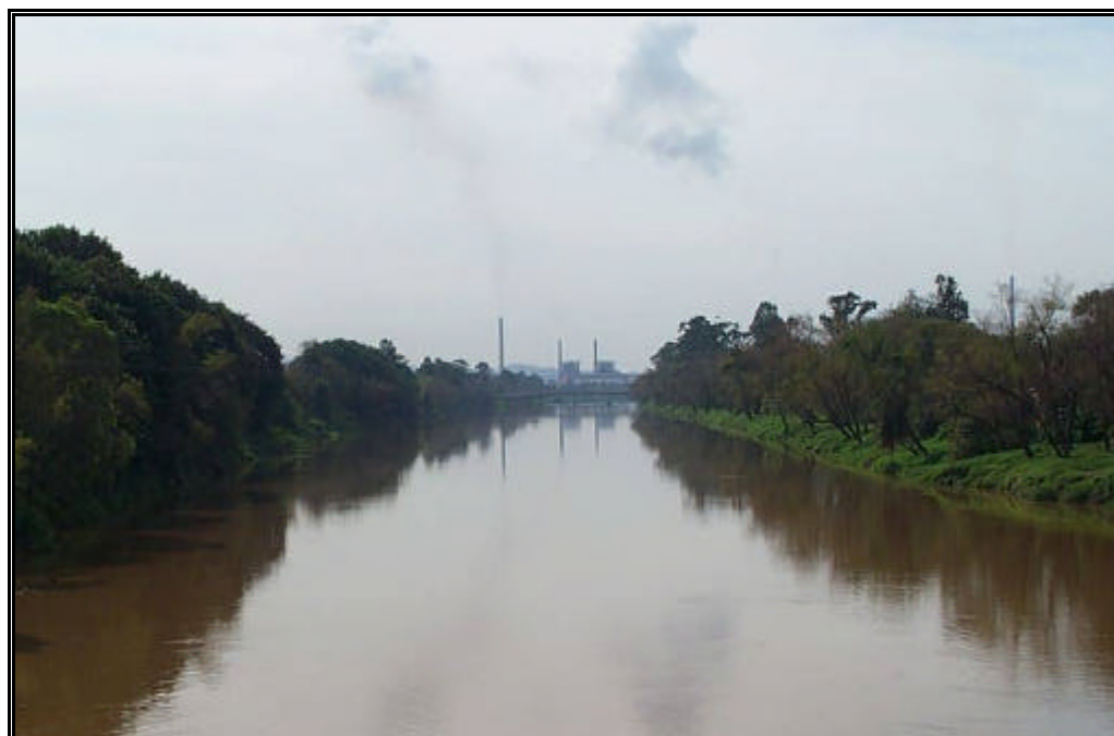
Foto 3.2.33 – Vista do Complexo Termoelétrico Jorge Lacerda à jusante da ponte Orlando Francallaci, em Tubarão
