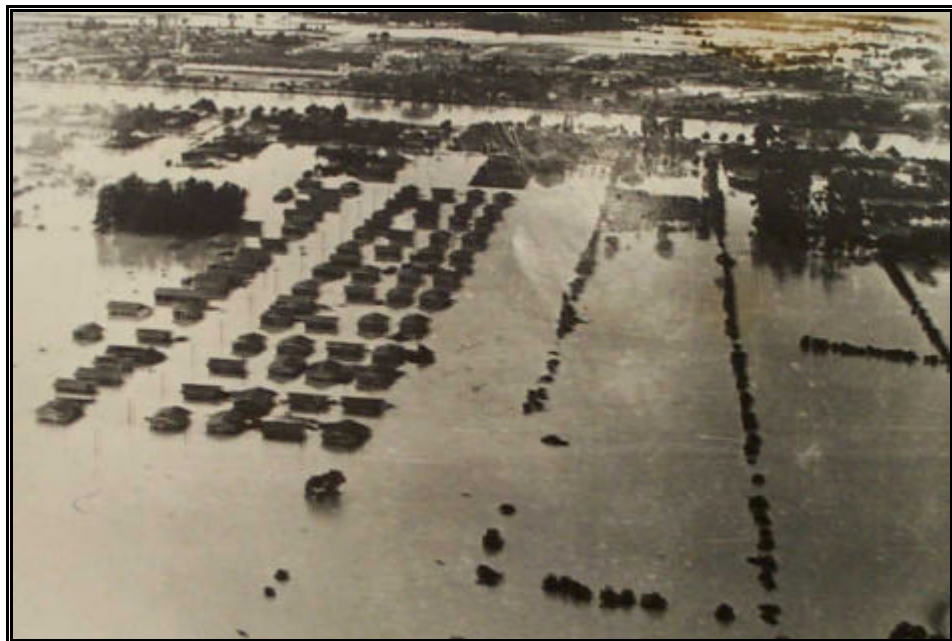
Foto 3.2.24 - Enchente de 1974 em Tubarão, Conjunto Habitacional Carlos Gomes FONTE: Arquivo Público e Histórico de Tubarão
