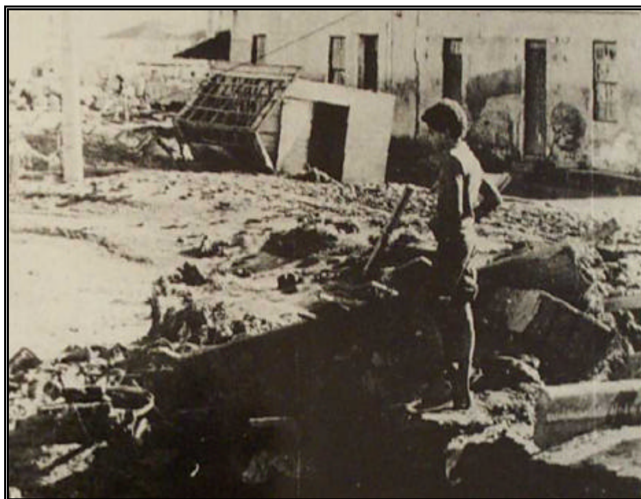
Foto 3.2.27 – Enchente de 1974 em Tubarão FONTE: Arquivo Público e Histórico de Tubarão
