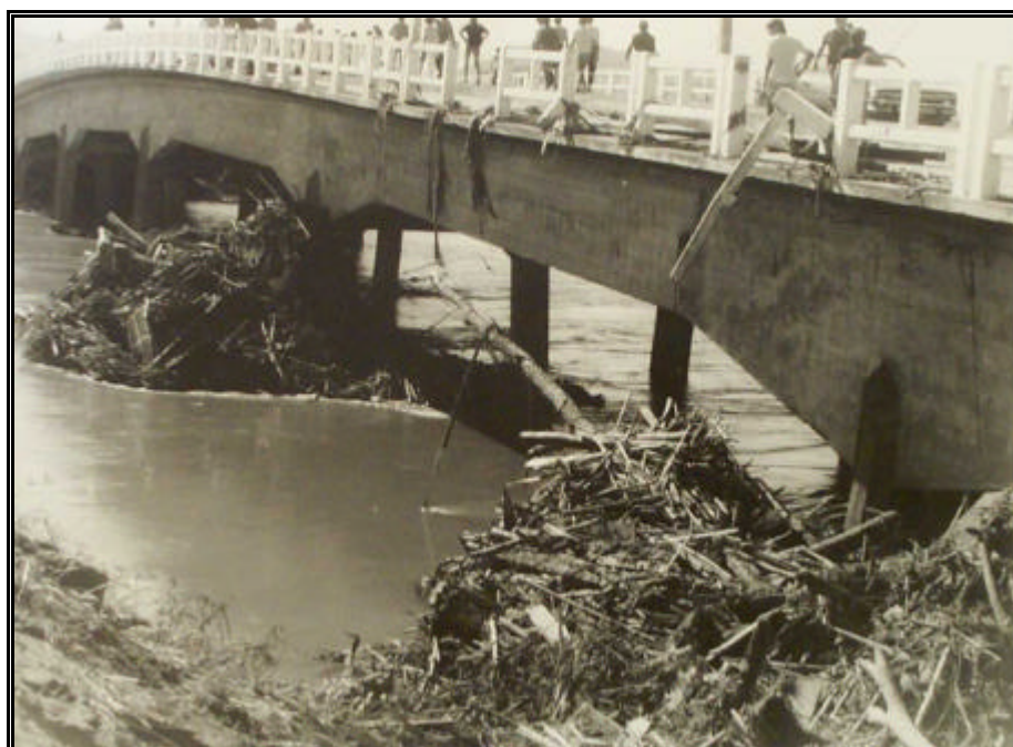
Foto 3.2.26 – Enchente de 1974 em Tubarão – Ponte Nereu Ramos FONTE: Arquivo Público e Histórico de Tubarão
