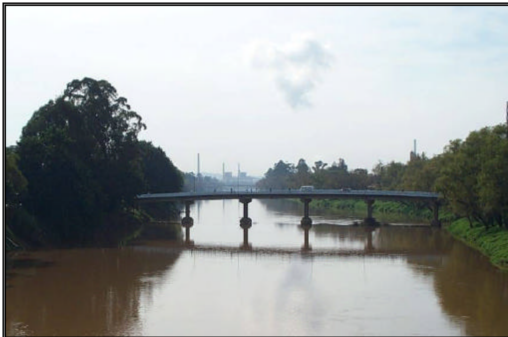
Foto 3.2.31 – Ponte Orlando Francallaci, em Tubarão, onde se localiza o posto fluviométrico 84580500 Localização em Coordenadas UTM: 694952 E, 6847959 N
