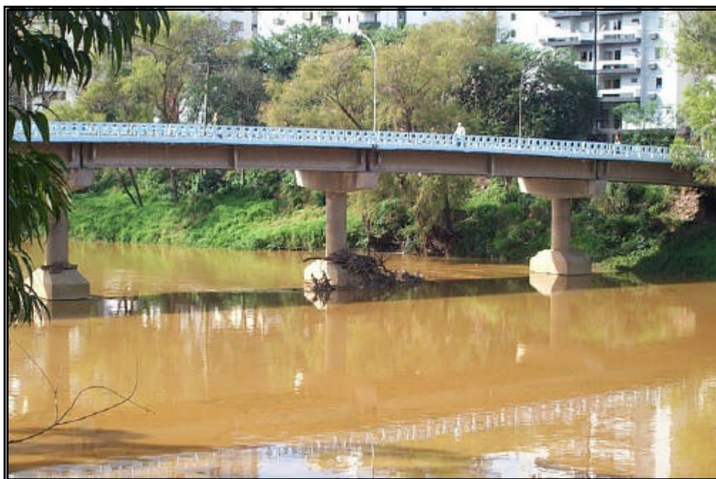
Foto 3.2.32 – Retenção de galhos e entulhos à montante da ponte Orlando Francallaci, em Tubarão
