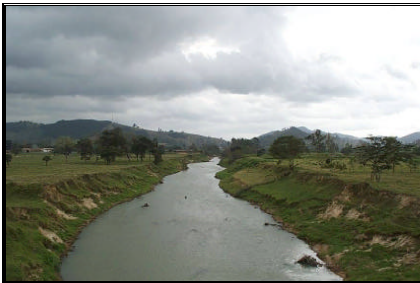
Foto 3.2.3 – Instabilização dos taludes ao longo do rio Capivari, devido a retificação do canal de drenagem e retirada da mata ciliar
