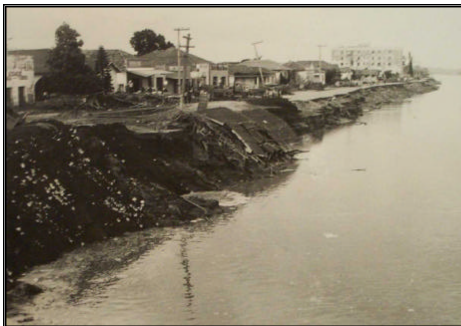
Foto 3.2.25 – Enchente de 1974 em Tubarão FONTE: Arquivo Público e Histórico de Tubarão
